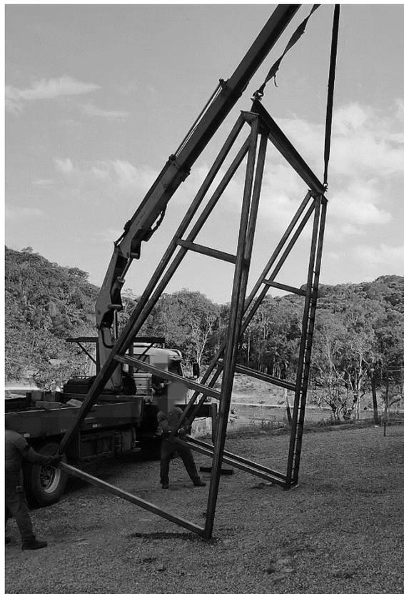
Caso pretenda utilizar o pórtico sem rodízios, faça o chumbamento deste ao solo instalando os chumbadores de 5/8" adequados para furos de Ø 17mm.
